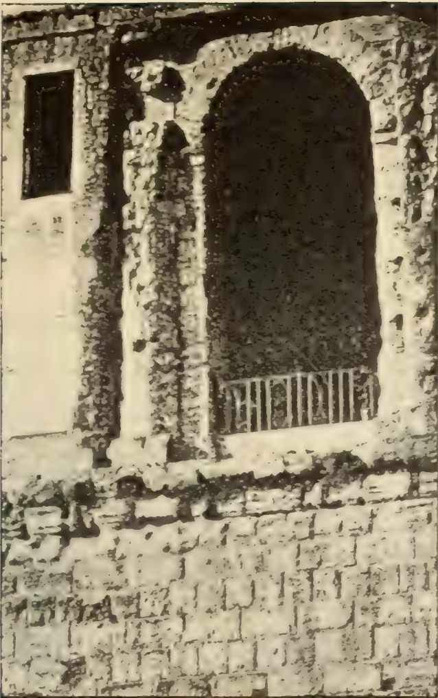
Abbildung 35. Das erhaltene Joch der Bogenhalle vor der Aus- besserung; nach Parker.
